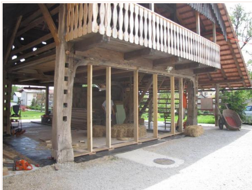
Gradnja lesene konstrukcije
